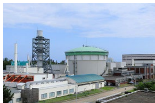
図 1：耐震補強工事後の JRR-3 全景 （JRR-3 ユーザーズオフィス HP より）
